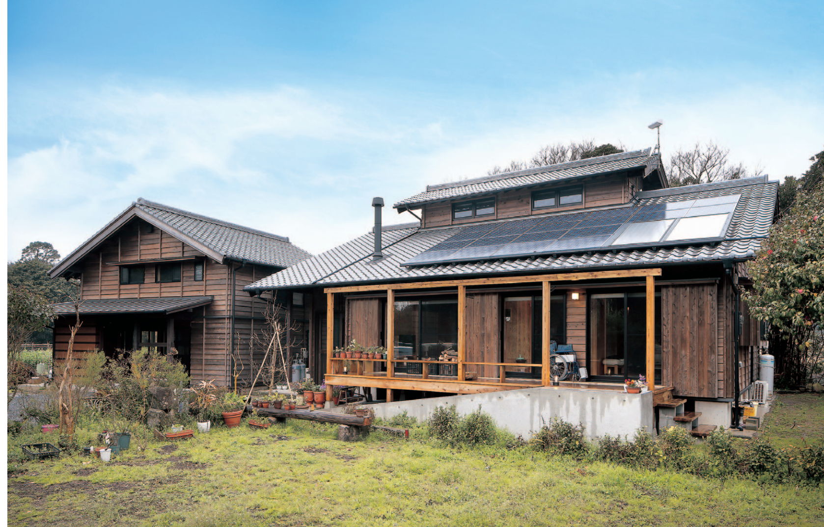
右が母屋、左が離れ。母屋は駐車場からウッドデッキへスロープを設け、そのまま室内へ車椅子で移動できるようになっている
