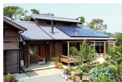
性能改善型リフォーム改修
